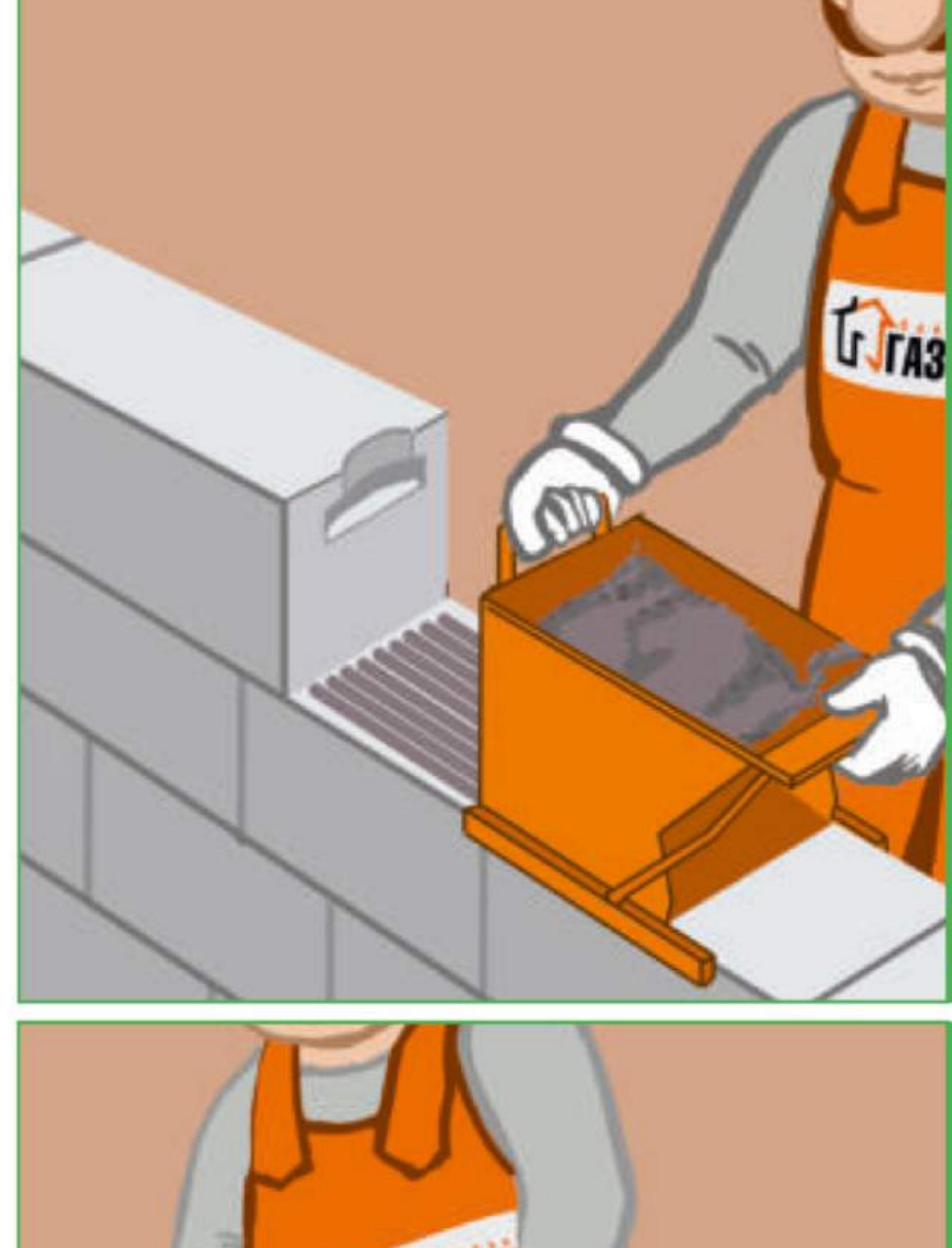
**Каретка для клеевого раствора** предназначена для нанесения клея на горизонтальную поверхность блоков во время кладки. Каретка позволяет дозировать клей, обеспечивая одинаковую толщину шва по всей кладке. Наиболее продуктивно использование кареток при кладке длинных и прямых стен. Выпускается шириной 300 и 400 мм
