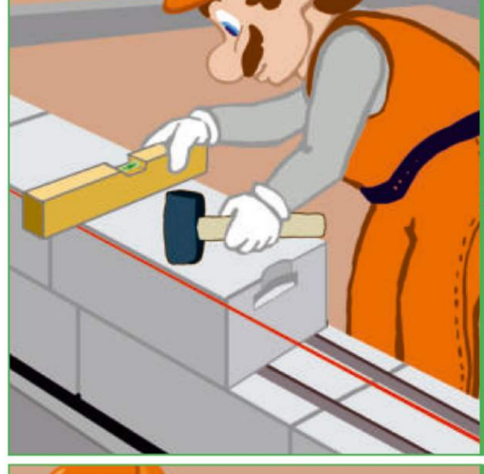
**Киянка** резиновая с деревянной ручкой применяется для точного позиционирования вновь уложенных блоков в кладке. Резиновая головка позволяет при работе избежать деформации газобетонных блоков.
